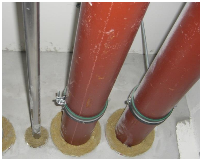
а – устройство канализационных выпусков в наружных стенах стоянки автомобилей, б – узел прохода чугунных трубопроводов через противопожарные преграды
