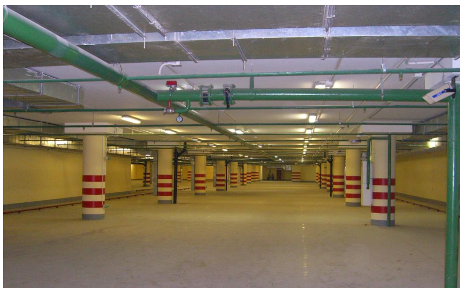
Рисунок 1 – Общий вид закрытой подземной стоянки автомобилей с
