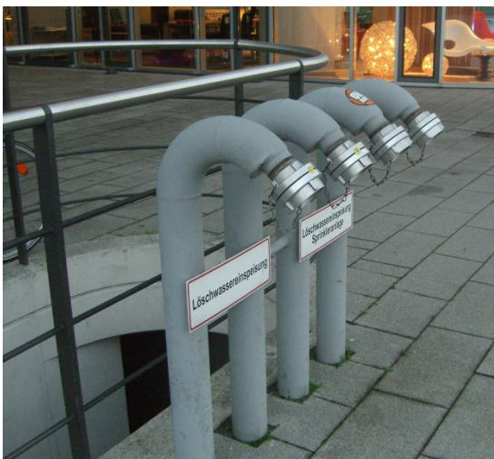
Рисунок 22 – Пример установки соединительных головок снаружи здания
