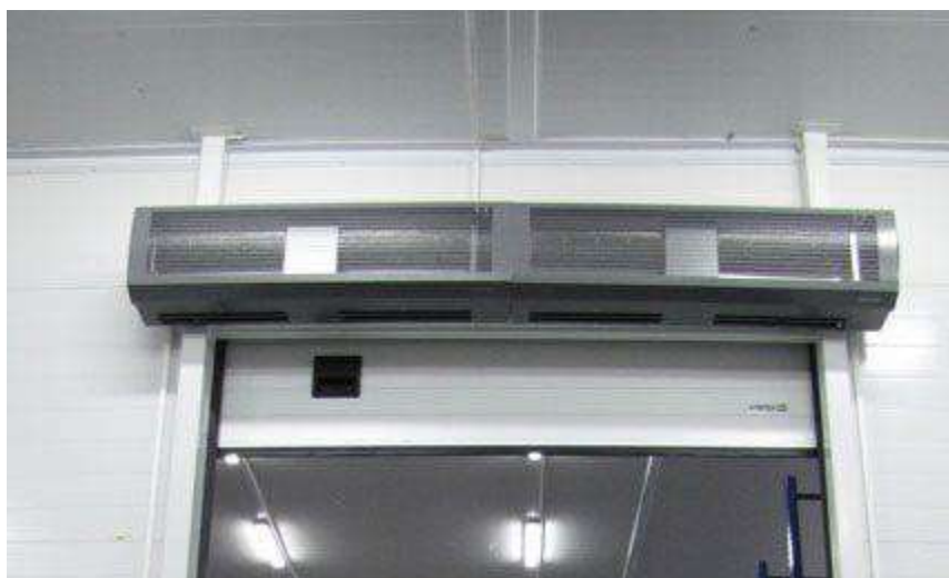
Рисунок 21 – Примеры устройства противопожарных ворот с воздушной завесой со стороны помещения хранения автомобилей посредством настильных воздушных струй от сопловых аппаратов
